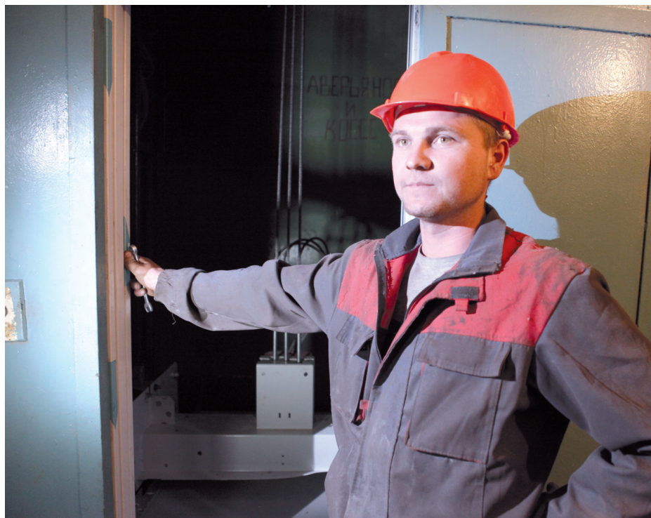
Работы по замене подъемников в разгаре.
